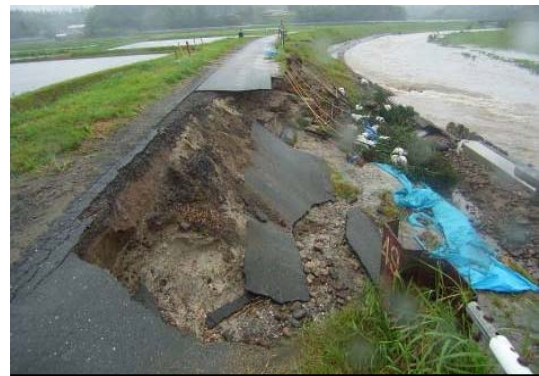
堤防の被災状況(始良川：H16.8)
