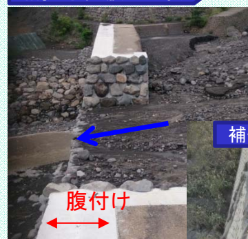
補強対策(腹付工事)
