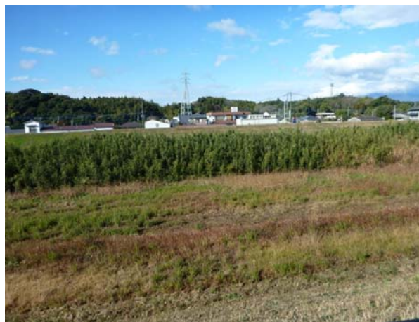
河道内樹木の繁茂状況(串良川)
