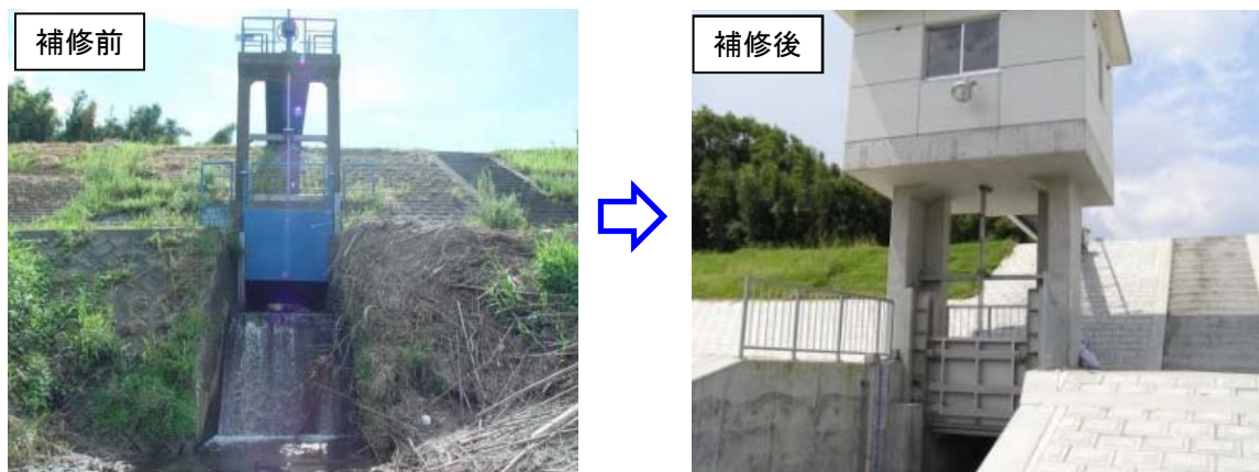
老朽化樋管補修事例
