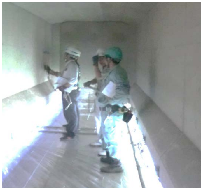
近接目視による点検状況
