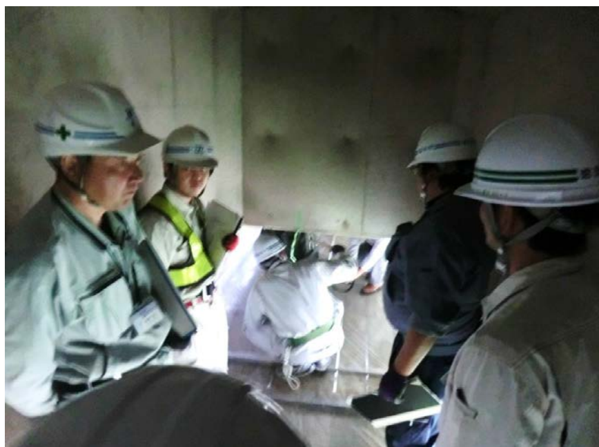
損傷状況の説明状況
