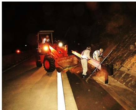
道路清掃作業
