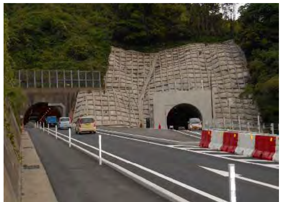
▲ 新海潟トンネル開通後の状況
