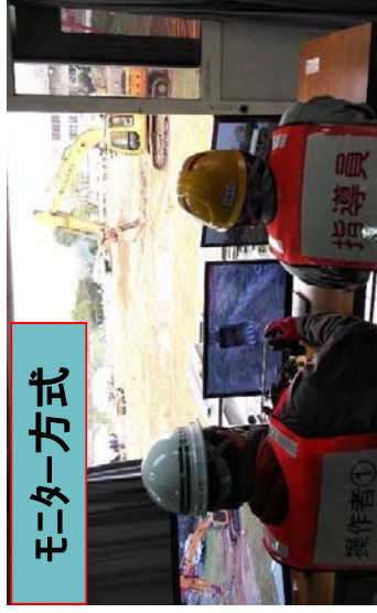
遠隔操縦式バックホウによる無人化施工機械操作体験
