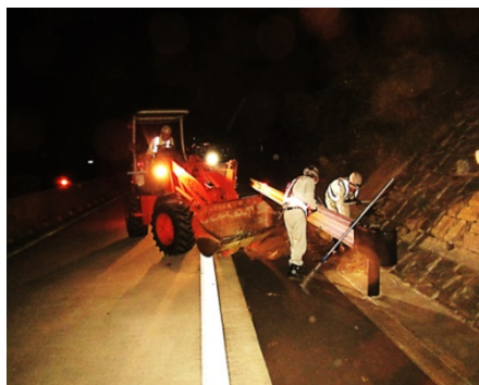
道路清掃作業
