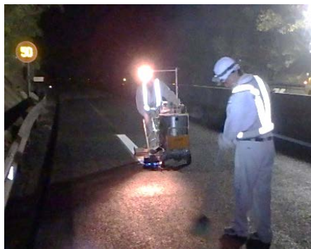
区画線の引直し
