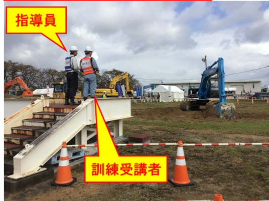
直接目視方式操作訓練
