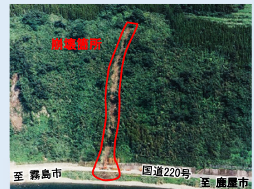
写真② 斜面の崩壊 遠景 (H5.8)
