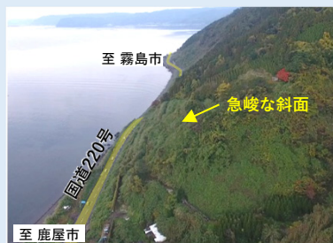
写真① 道路沿線の斜面状況
