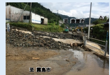
写真④ 国道への土砂流入 (H29.7)
