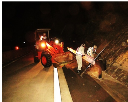
道路清掃作業
