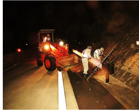
道路清掃作業
