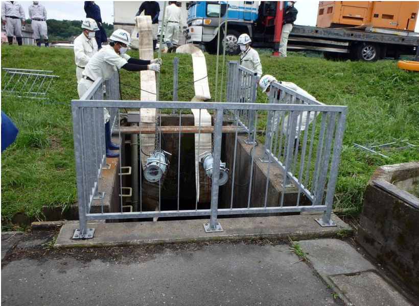
排水ポンプ吊り降し(新川第9樋管)
