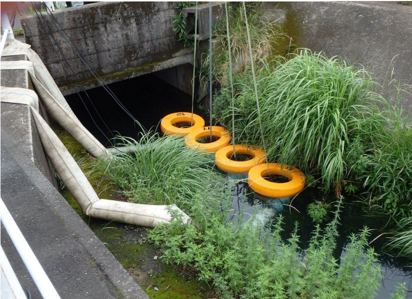
排水ポンプ吊り降し(新川第9樋管)
