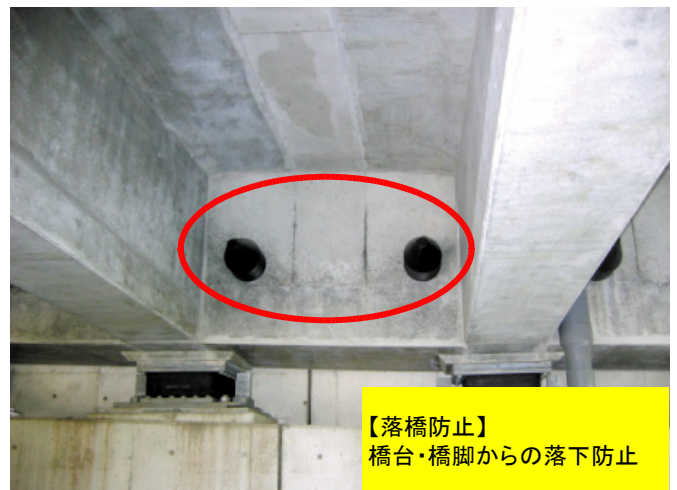
【橋脚補強】 コンクリート・繊維巻立て
