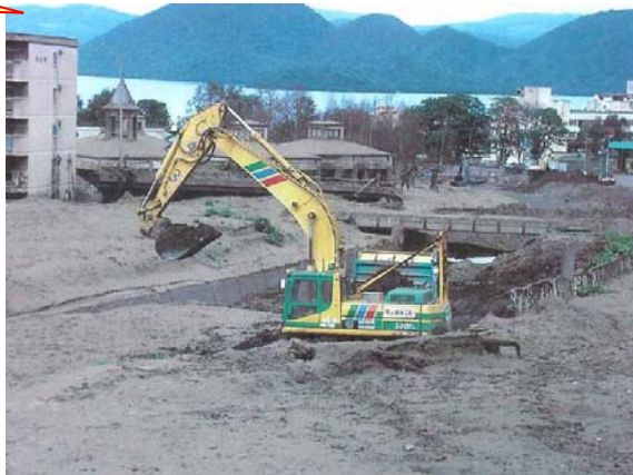
無人化施工による堆積土砂の除去 (2000年有珠山:北海道)
