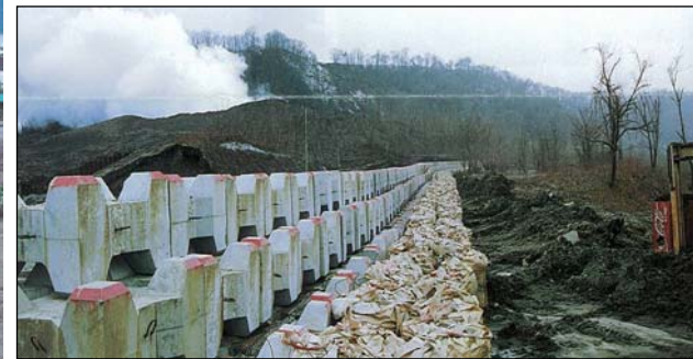
緊急的に配置されたブロック積の導流堤 (2000年有珠山:北海道)
