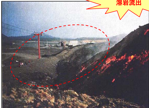
1983年エトナ火山(イタリア)の事例 (土堤により、溶岩の流入を止める。)
