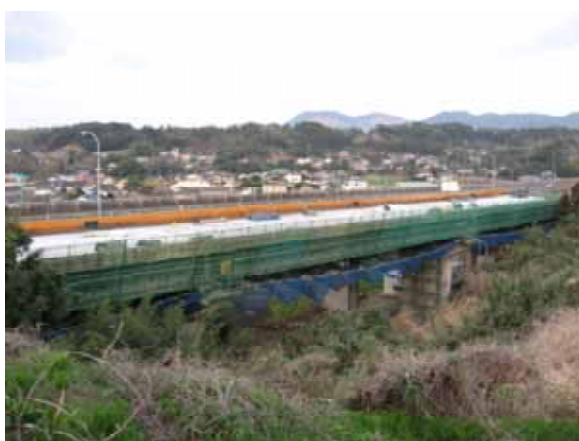
鹿屋大橋の工事状況写真
