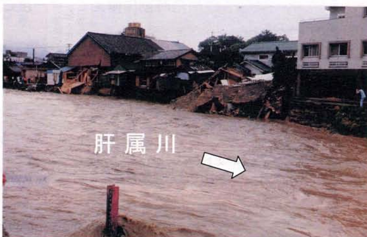
昭和51年6月出水 鹿屋市街地部
