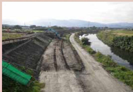
堤防の改良工事 (串良川左岸 岩弘地区)
