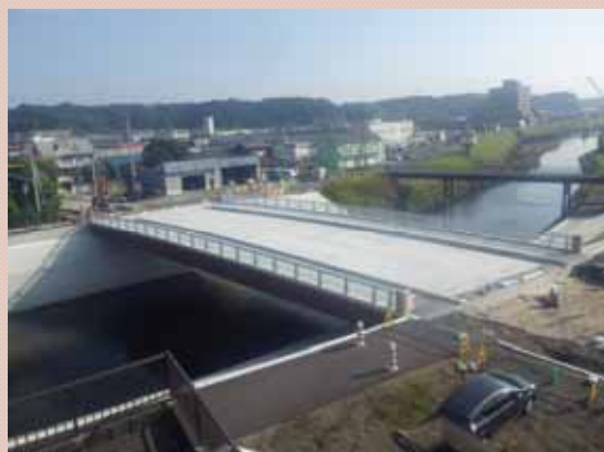
沢尻橋の架替え工事 (肝属川16k 600付近)
