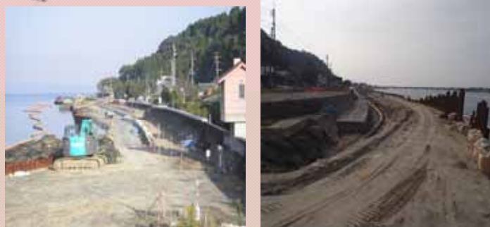
特殊堤工事 (高潮・耐震対策) (肝属川右岸 0k 0 ~ 0k 500付近)
