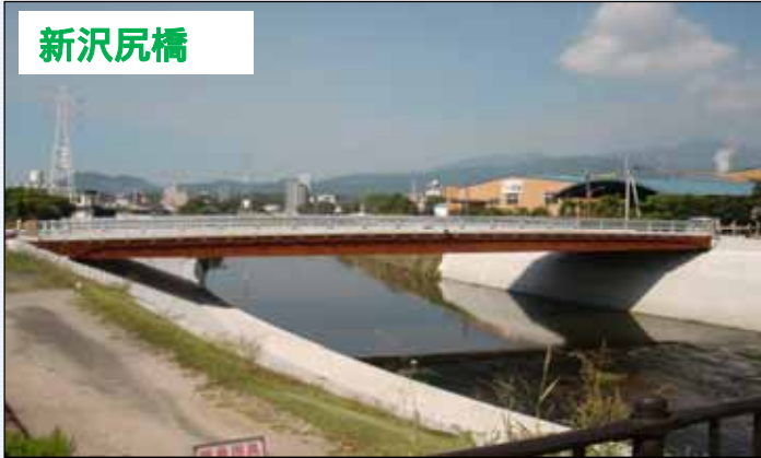
(橋長:44m 幅員:16m コンクリート合成床板橋)
