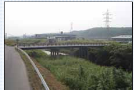
旧沢尻橋(昭和39年竣工) 橋長:35m 幅員:5.5m
