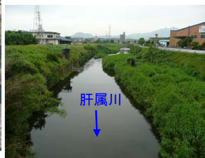
沢尻橋より上流を望む
