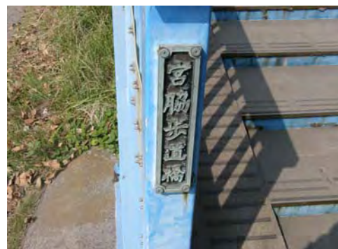
宮脇歩道橋 橋名板
