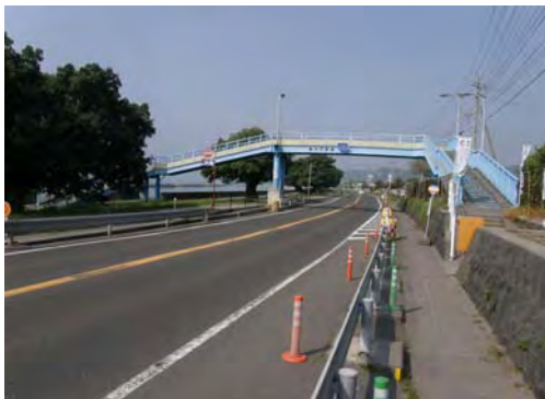
宮脇歩道橋全景
