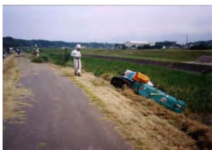
大型機械の遠隔操作による堤防除
