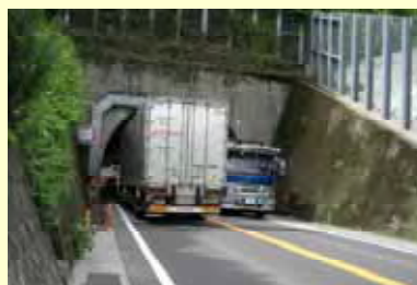
海潟トンネル（現道状況）
