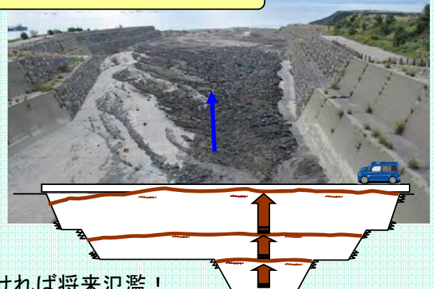
土石流2~3回での堆砂状況
