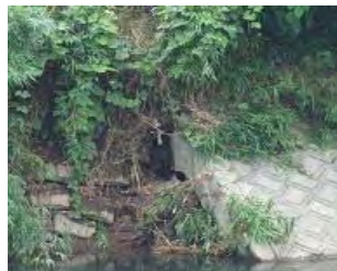
護岸端部の洗堀状況
