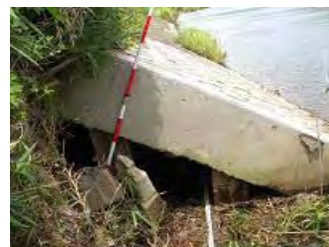
護岸端部の洗堀状況
