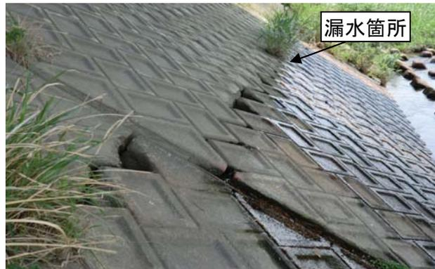
漏水対策(護岸補修)箇所
