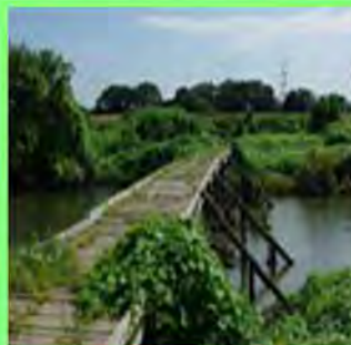
ピオトープの整備
