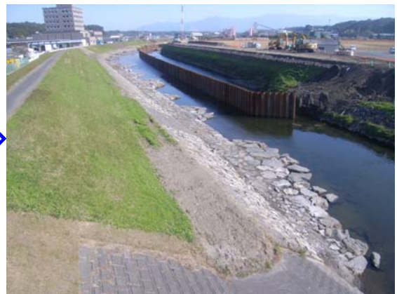
堆積土砂掘削後
