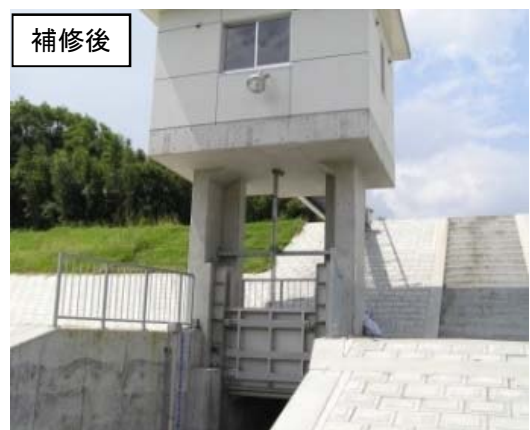
老朽化樋管補修事例
