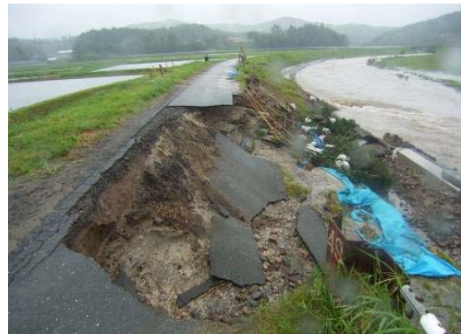
始良川における堤防の被災状況 (平成16年8月)
