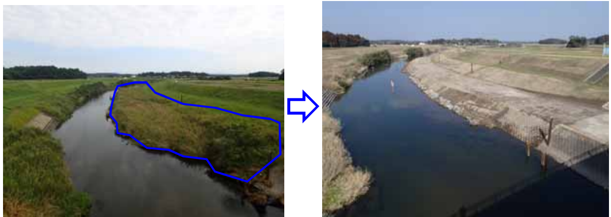
堆積土砂の状況
