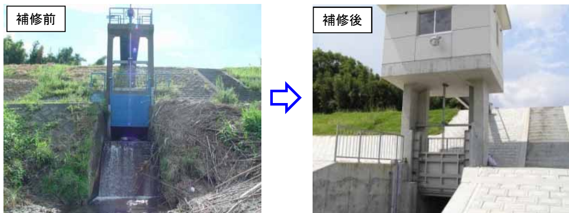
老朽化樋管補修事例
