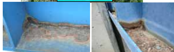
樋管ゲートの腐食状況
