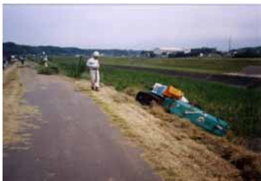
大型機械の遠隔操作による堤防除草
