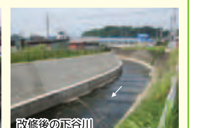
改修後の下谷川
