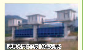
波見水門(平成16年完成)
