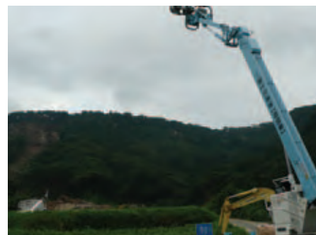
夜間監視用の照明車
