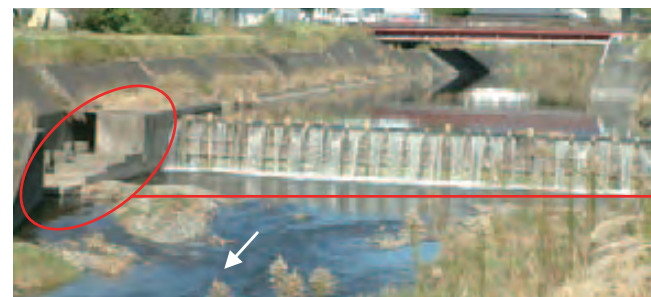
魚道の整備事例（新和田井堰：肝属川本川）
