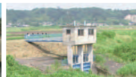
樋管(中郷第3樋管:串良川)
