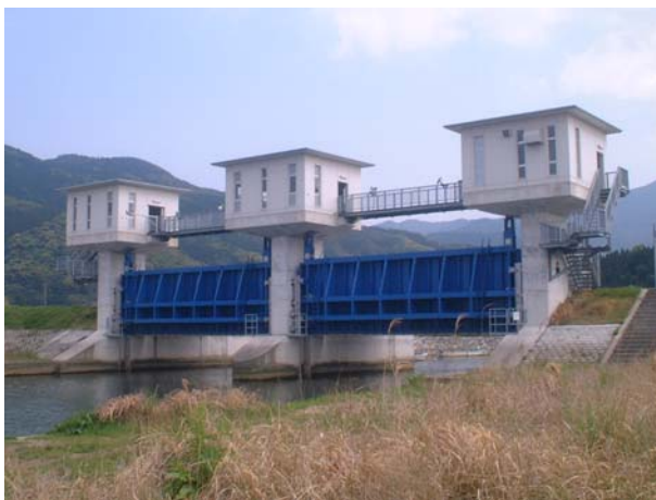
写真 2.1.2 波見水門（平成 16 年度完成）
