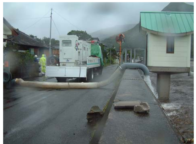
写真 2.1.3 排水ポンプ車による内水排除
