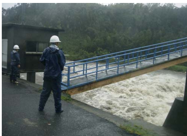
写真 2.1.12 洪水時の巡視状況
