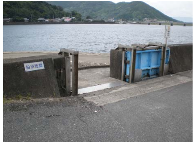
写真 2.1.11 陸閘門 (柏原陸閘：肝属川本川)
