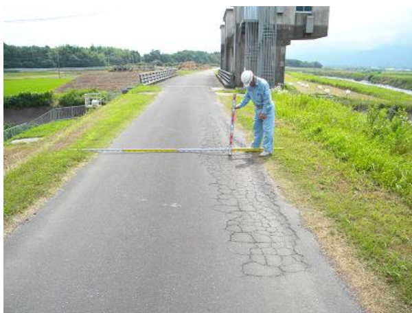
写真 2.1.7 堤防天端舗装の補修前・後
