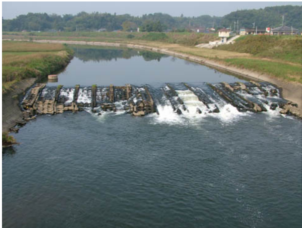
写真 2.1.8 床止め (宮下床止：肝属川本川)
