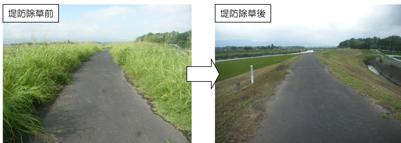
写真 4.3.3 堤防除草の実施前・後
