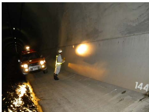
写真 4.3.9 鹿屋分水路の点検
