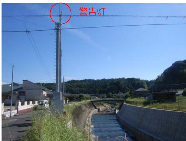
写真 4.3.12 川の警告灯（支川下谷川）
