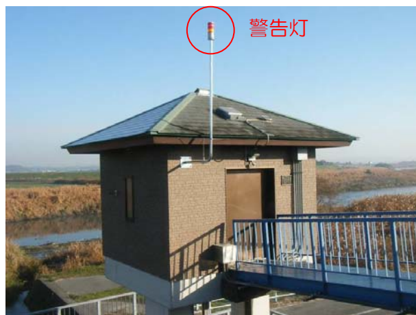
写真 4.3.13 樋管の警告灯
