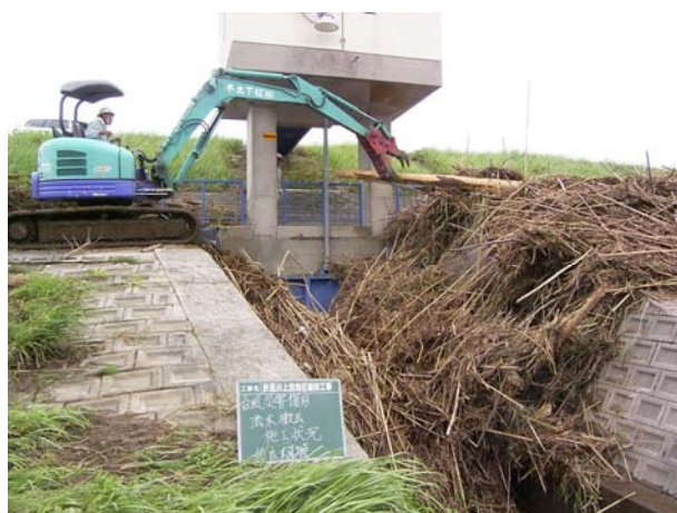
写真 4.3.6 流木、塵芥の除去
