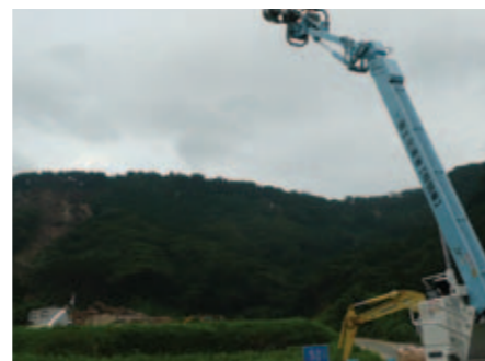
夜間監視用の照明車
