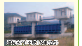
波見水門(平成16年完成)
