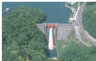
● 高隈ダム(支川串良川)
