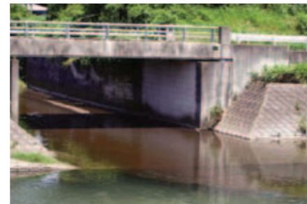
排水路からの汚水流入(肝属川上流)
