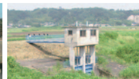
樋管(中郷第3樋管:串良川)
