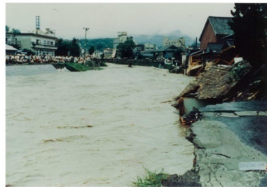
写真 1.2.3 肝属川 18/200 付近 (朝日橋上流左岸) 被害状況
