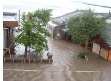
写真 1.2.13 肝属川左岸 10/000 付近堤内地浸水状況
