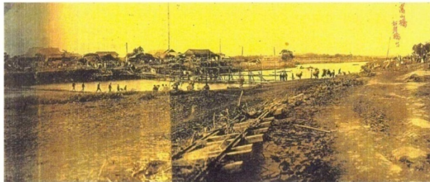
写真 1.2.1 高山川 2/300 付近(高山橋)被害状況
