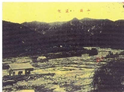
写真 1.2.2 肝付町後田野付近被害状況
