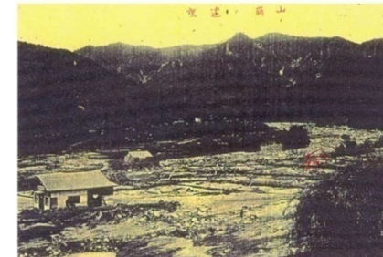
写真 1.2.2 肝付町後田野付近被害状況
