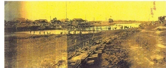
写真 1.2.1 高山川 2k300*付近(高山橋)被害状況
