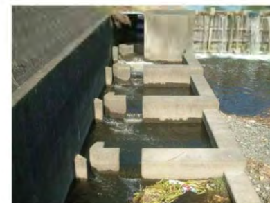
写真 4.2.4 魚道の整備事例(新和田井堰: 肝属川本川)
