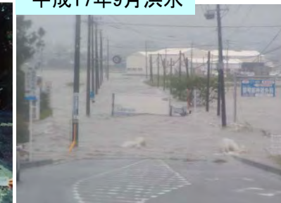
肝属川右岸8/000付近 (前田地区)浸水状況
