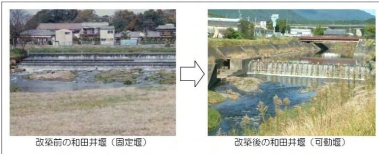
写真 4.2.1 堰の改築事例（和田井堰:肝属川本川）
