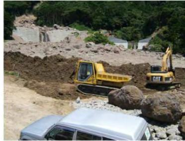
写真 4.3.17 遠隔操縦による危険箇所での
