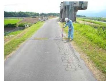
写真 2.1.7 堤防天端舗装の補修前・後
