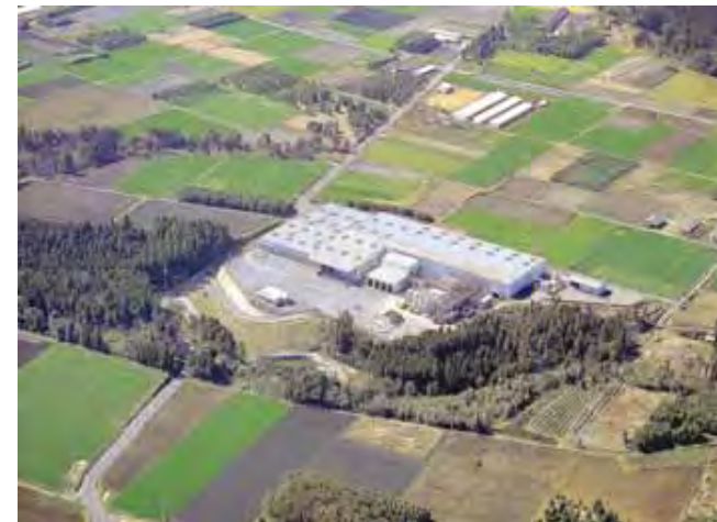
鹿屋市畜産環境センター全景写真
