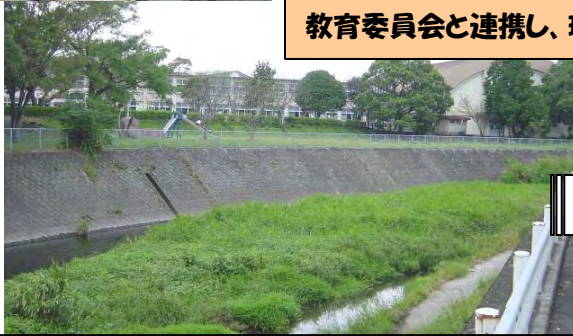
着工前の状況(単調な護岸のため、流れに変化が乏しい)
