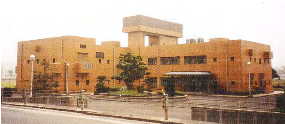
下水処理センター全景 (鹿屋市の公共下水道(パンフレット)より)
