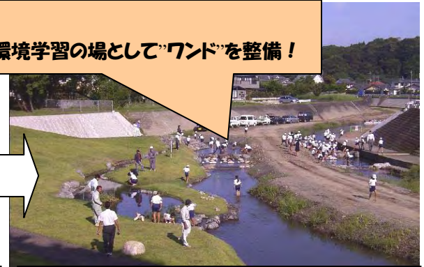
完成後の状況(ワンドを作り、多様な流れが出来た)
