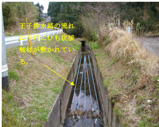
ひも状接触酸化法による浄化施設の設置状況
