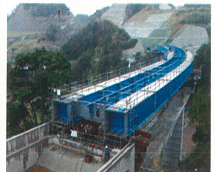
〔まさかり橋(仮称)上部工架設状況〕
