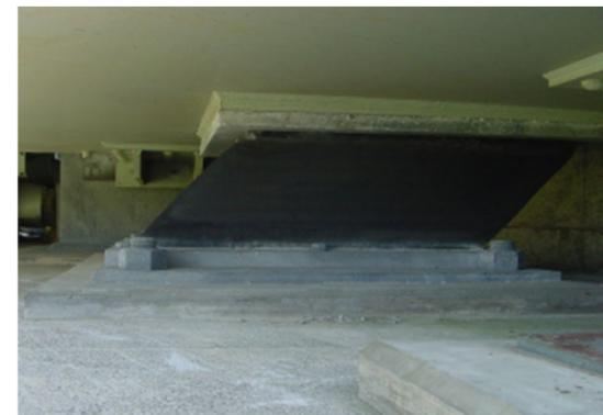
写真ーゴム支承の変形状況例
