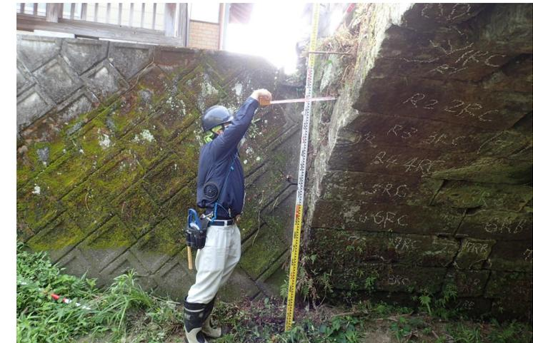
写真2.2.4-7 はらみ出しの計測状況の事例②
