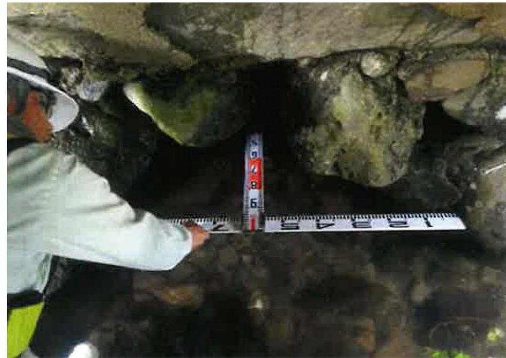
写真2.2.2-2 洗掘状況・背面状況の確認
