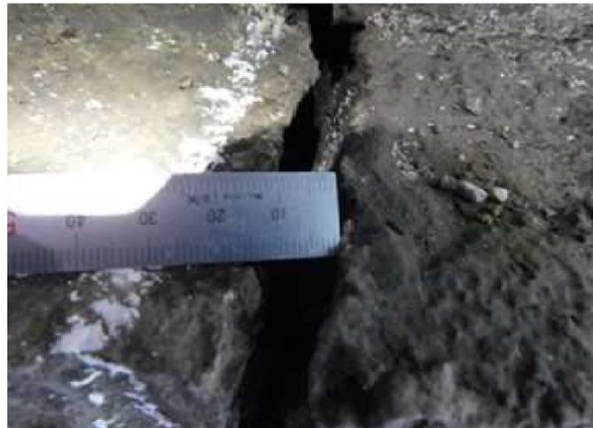
写真2.2.2-5 橋台のひびわれの発生事例(15mm程度)
