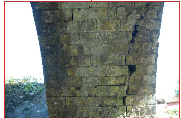
写真2.2.3-4 輪石の連続的な破断(亀裂)・抜け落ちの事例
