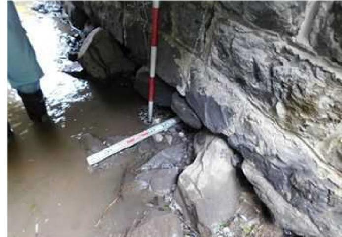
写真2.2.2-4 橋台の洗掘の計測事例
