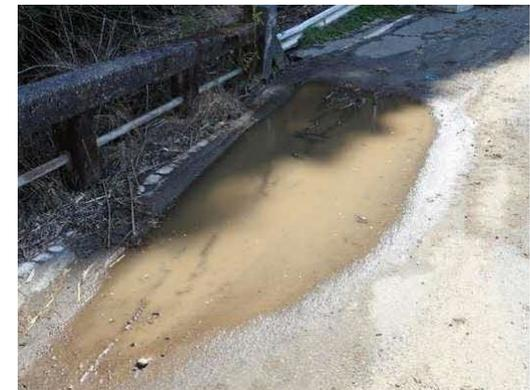
写真2.2.4-2 直上の路面に滞水
