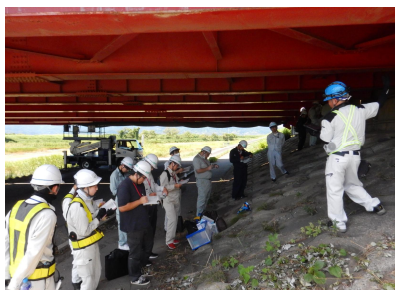
橋梁初級Ⅰ研修 現地実習
