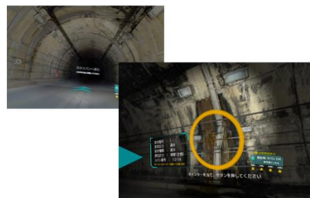
トンネル初級研修 道路トンネル点検VRモデル
