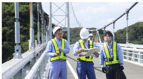
樋島大橋（熊本県 上天草市）
