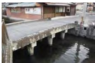
石桁橋：中の橋（佐賀市）
