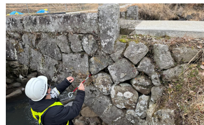
道路橋石橋の現地計測
