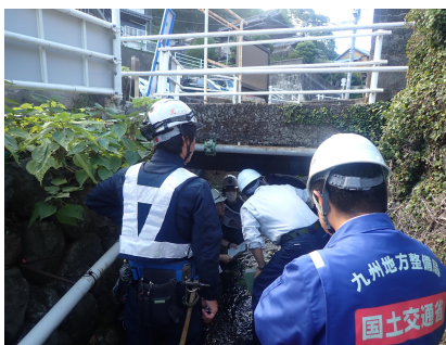
橋梁点検研修(地方公共団体管理橋梁)
