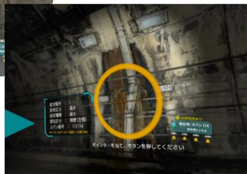
道路トンネル点検VRモデル
