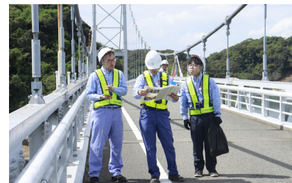
直轄診断：樋島大橋(熊本県 上天草市)
