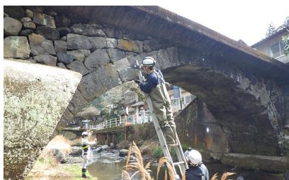
道路橋石橋の現地計測
