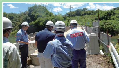
橋梁の変状調査
