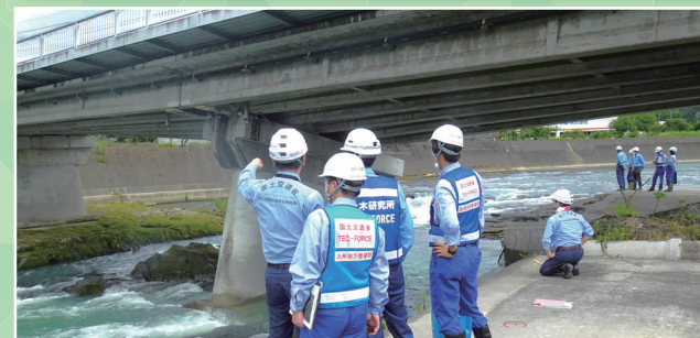
橋梁の被災調査
