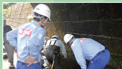
石橋の変状調査
