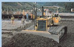
タンピングされたコンクリートを、ブルドーザによって1リフトの仕上がり厚100cmを確保するため、約110cmの厚さに敷均します。
