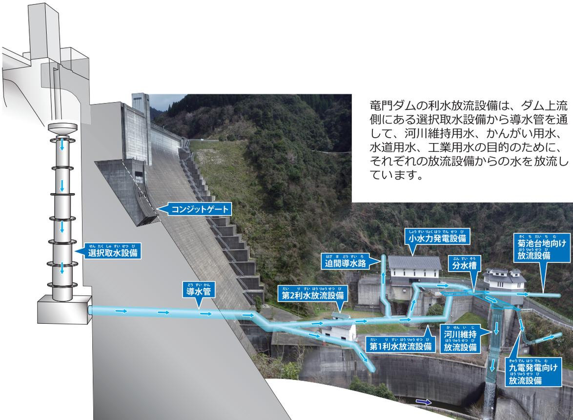
竜門ダムの利水放流設備は、ダム上流側にある選択取水設備から導水管を通して、河川維持用水、かんがい用水、水道用水、工業用水の目的のために、それぞれの放流設備からの水を放流しています。
