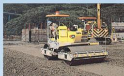
コンクリートの締め固めは、新たに開発された振動ローラSD450を使用し、時速1km程度で12回（6往復）の振動転圧を行います。
