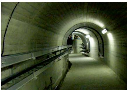
ダム堤体の内部に設けられた点検や観測のための通路です。内部には計測機器、監視カメラが設置されています。また、放流施設もここから入ります。竜門ダムでは、全長およそ1 kmにもなります。
