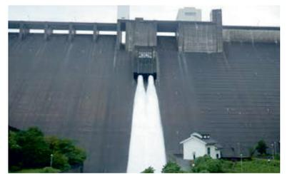
ダムに洪水の一部を貯め洪水調節を行うことで、川の増水を緩和し、下流地域の被害を減少させることができます。
