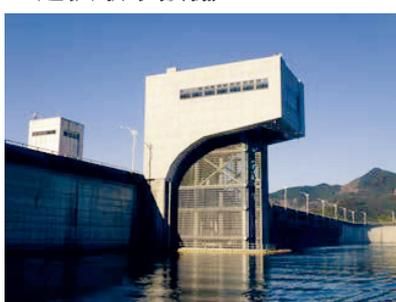
平常時にダム湖より河川に水を流す設備で、農業用水・都市用水・河川に必要な水はこの設備を通して補給します。平常時は上流河川水の水温に近い層の水を、洪水後には上の方の澄んだ水を流し環境への影響を軽減します。
