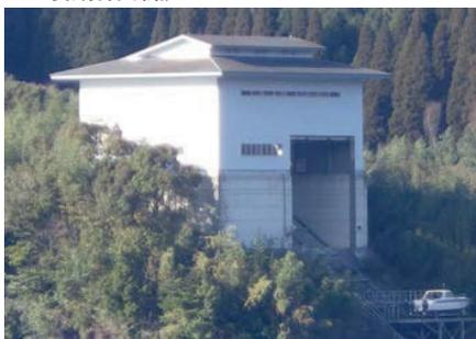
貯水池の巡視や作業で使用するボートを搬出、格納するための設備です。ボートは普段陸上にあげておき、使用する際にはこの設備で船を湖面までおろします。
