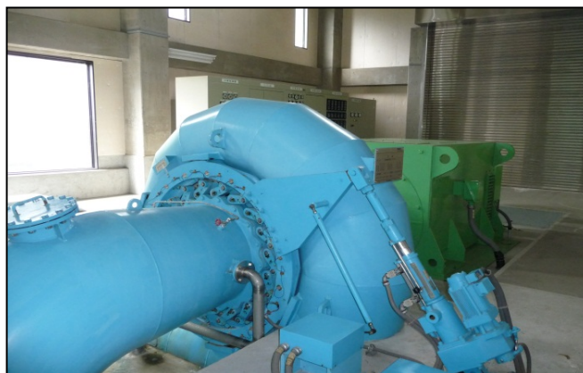
水車及び発電機
