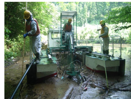
貯水池内の流木処理状況
