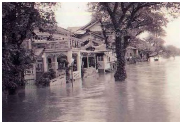
本川33km付近の氾濫状況(山鹿市) (昭和28年6月)
