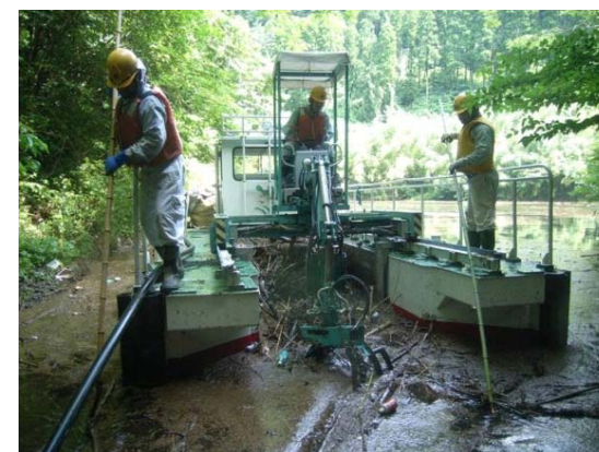
貯水池内の流木処理状況
