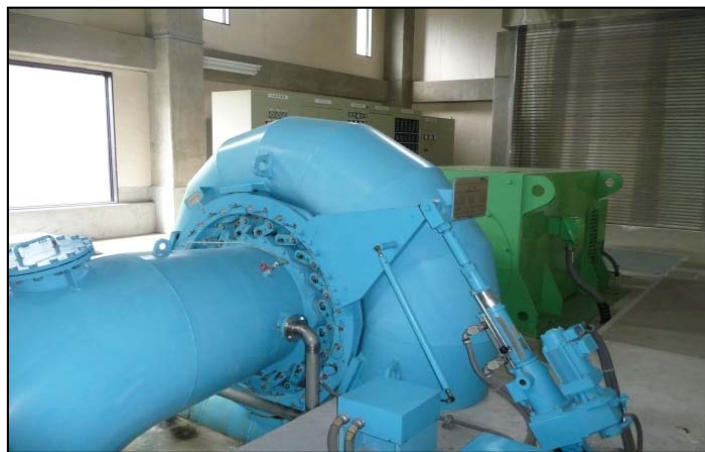
水車及び発電機
