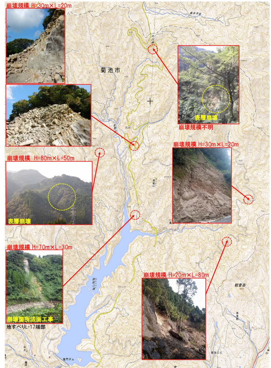
流域内の主な崩壊地の状況（2017年10月確認）
