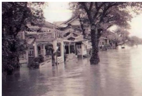
本川33km付近の浸水状況 (山鹿市 昭和28年6月)
