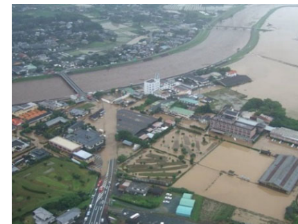
植木温泉街の浸水状況 (熊本市 平成24年7月)
