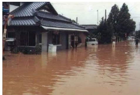
支川合志川6.5km付近の浸水状況 (熊本市 昭和57年7月)
