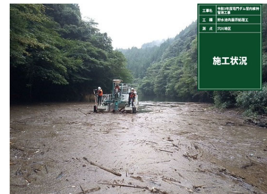
貯水池内の流木処理状況 (令和3年9月)
