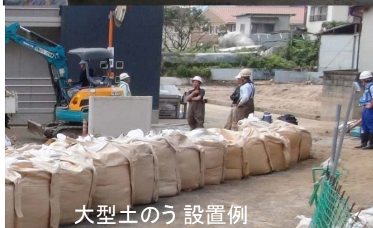
大型土のう袋 積み込み状況
