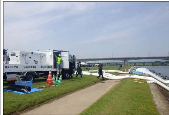
排水ポンプ車による緊急排水訓練 (筑後川・矢部川総合水防演習)
