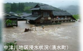
中津川地区浸水状況(湧水町)
