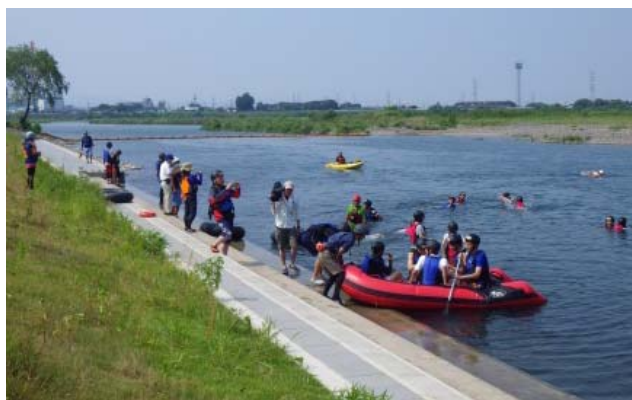
○球磨川(熊本県) [⑰八代市 新萩原橋周辺地区] 水際へ安全近づけるよう階段護岸を整備。水浴場など河川の水面利用向上に繋がっている。
