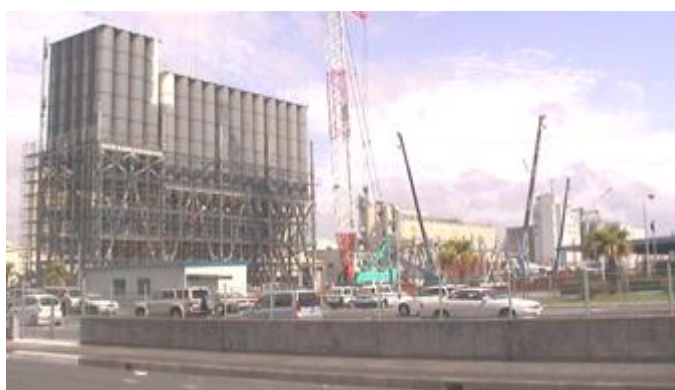
飼料生産設備増設状況(A社)
