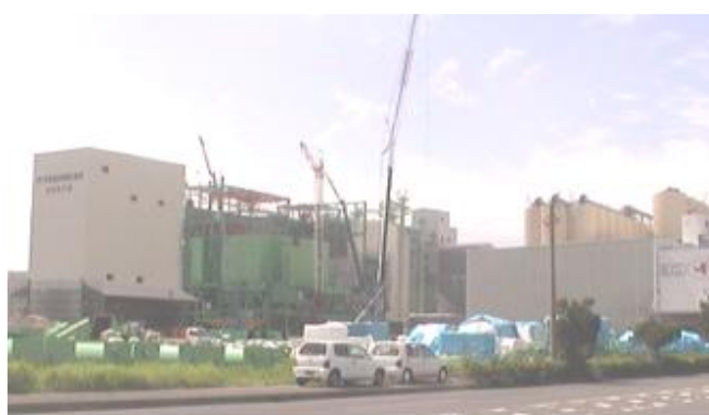
飼料生産設備増設状況(C社)
